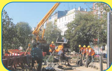
Wybudowano sieć wodociągowo- -kanalizacyjną w 5 ulicach i kanalizacji sanitarnej w 6 ulicach - dotacja 186.990 zł
