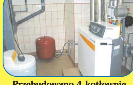
Przebudowano 4 kotłownie węglowe na gazowe - dotacja 140.410 zł
