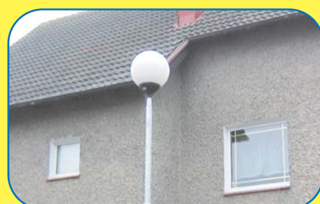
Oświetlenie uliczne wykonano przy ulicach: Asnyka, K. Wielkiego, Nowej - dotacja 40.000 zł
