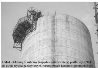
układ stałociśnieniowy i sterowanie proporcjonalne samojedznej platformy P-904 do cięcia wysokogabarytowych
