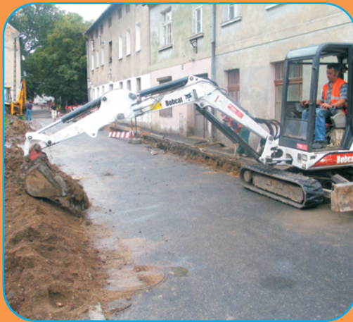
Przebudowa sieci wodociągowej i kanalizacji w ulicach Ściegienego, Rynek, K. Jadwiży, Rejtana, P. Skarży, Chmielnej, Moniuszki i Placu Zamkowym
