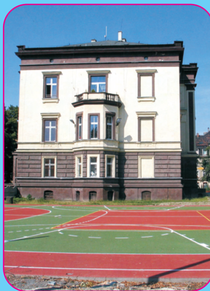
Budowa boiska przy SP3
