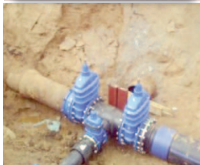
Budowa sieci wodociągowej wraz z przyłączami - etap I ul. Małachowskiego, Pl. Konstytucji 3 Maja, Niemcewicza; - etap II i III ul. Witosa, Mickiewicza, Bohaterów Getta Warszawskiego
