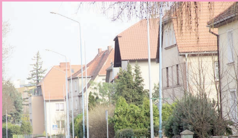
Budowa oświetlenia drogowego - ul. Paderewskiego
