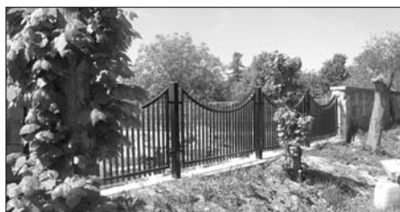
* rozbudowa cmentarza komunalnego - zakończono budowę ogrodzenia rozbudowanej części cmentarza;
