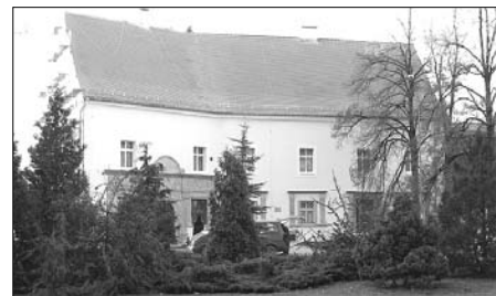
* remont elewacji i dachu Muzeum Regionalnego - inwestycja dofinansowana przez Ministra Kultury i Dziedzictwa Narodowego w ramach programu operacyjnego pn. „Dziedzictwo Kulturowe”;
