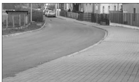
* budowa ul. Łużyckiej - dofinansowanie Legnicka Specjalna Strefa Ekonomiczna;
