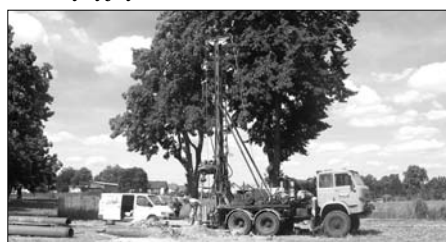
* budowa kompleksu sportowo-rekreacyjnego przy MOKSiR - zakończono prace przygotowawcze - ogrodzono, zniwelowano i obsiano trawą teren oraz wykopano studnię głębinową;
