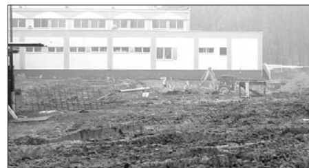
* budowa międzyszkolnego basenu krytego przy Szkole Podstawowej nr 4 w Chojnowie.
