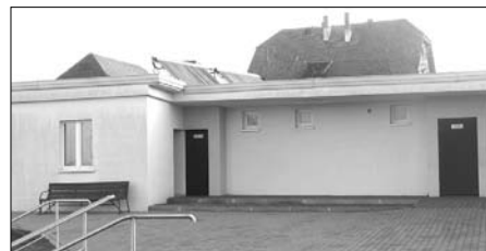
* solary na dachu budynku socjalnego KS Chojnowianki;
