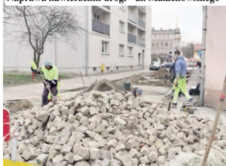
Naprawa nawierzchni drogi - ul. Małachowskiego
