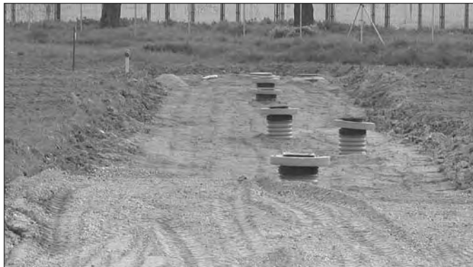
Uzbrojenie terenu pod budownictwo jednorodzinne przy ul. Bielawskiej
