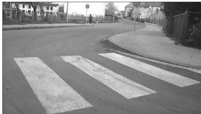
Budowa ul. Łużyckiej
