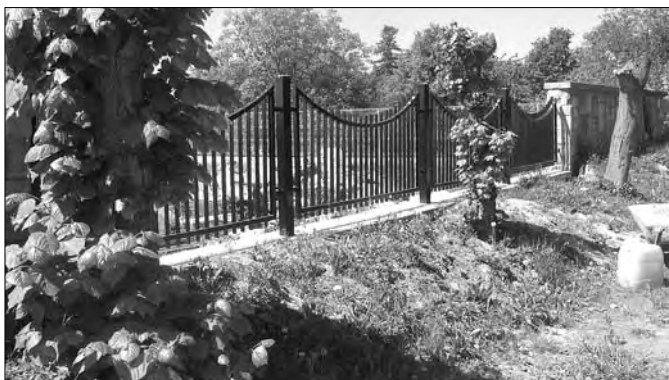
Ogrodzenie rozbudowanej części cmentarza komunalnego
